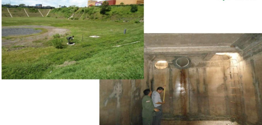
Figura 2.28. Sistema de detención, torre el pedregal. [Fuentes: COAMSS/ OPAMSS.]
