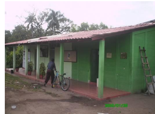
FOTO III. 24 Departamento de Gestión de Riesgos y Unidad de Prevención de Desastres.
