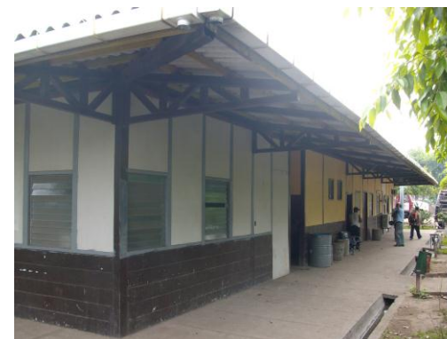
FOTO III. 23 Instalaciones provisionales. Gerencia de Gestión Ambiental
