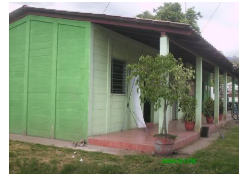
FOTO III. 26 Instalaciones actuales Departamento de Gestión y Riesgos. Unidad de Prevención y Control de Desastres.
