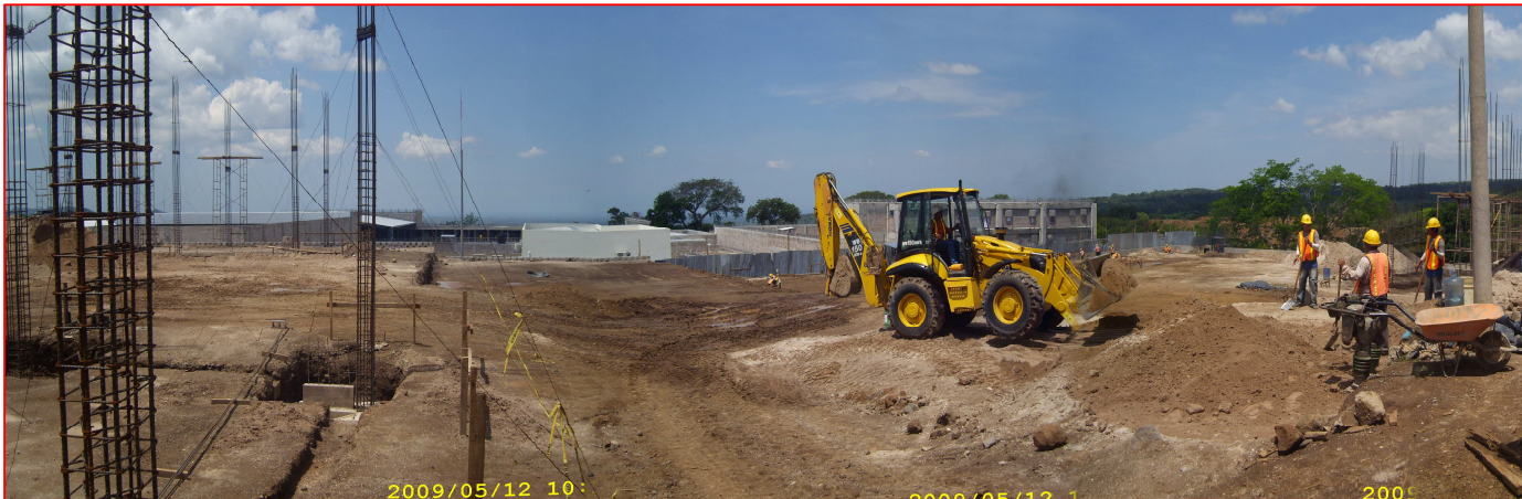
Imagen 7.d, Ultimo Avance fase 2 de la obra Actualmente mayo 2009
