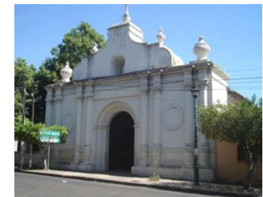
Imagen3. Iglesia Asunción de Izalco construida en 1576
