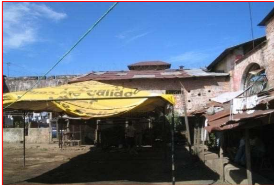
Imagen 11..d, Condiciones precarias
