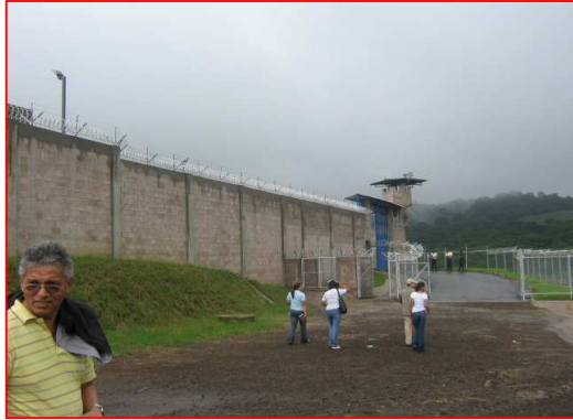
Imagen 2.d, Vista del Exterior fase 1
