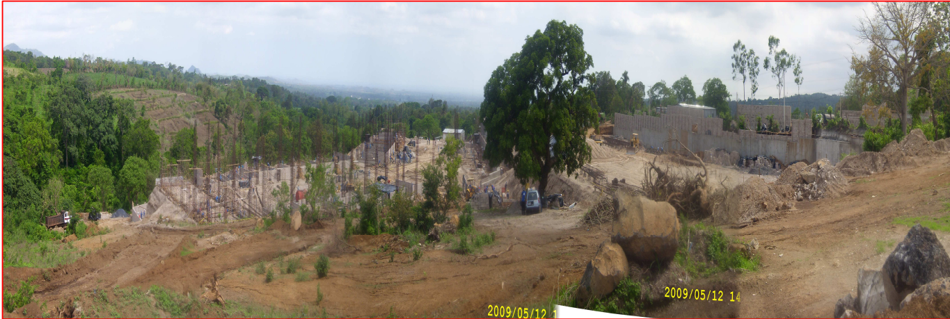
Imagen 6d, Vista panorámica de fase 2 y 3 en construcción
