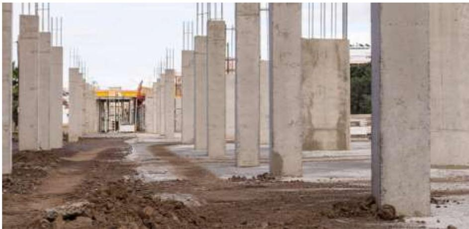
*Ilustración 53: Ejemplo de columna de concreto armado.*
