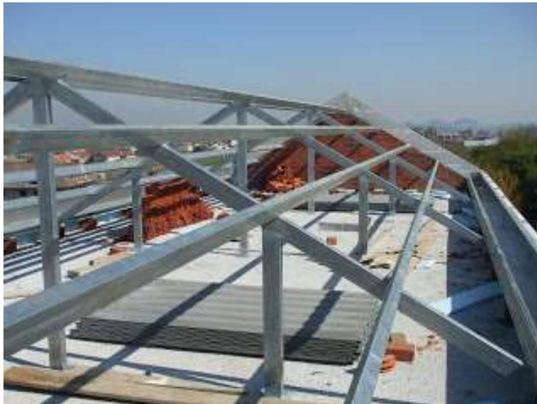
**Ilustración 54:** Ejemplo de estructura de techo metálico.
