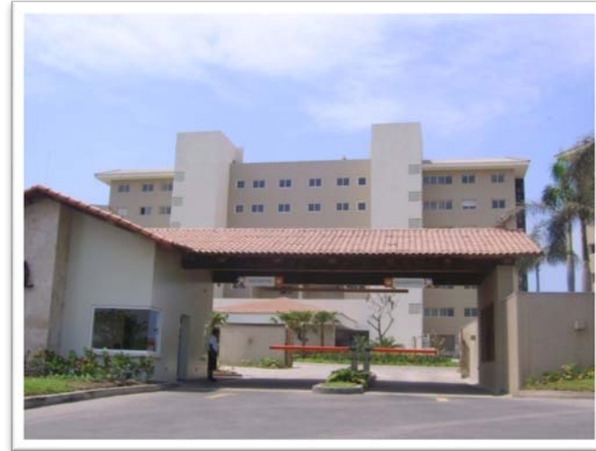
Imagen 36. Arriba Fachada Principal Condominios Costa Real
