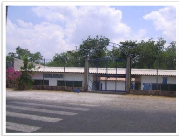
Imagen 20. Centro Escolar Caserío El Conchalito Padilla, Km 69 ½ Boulevard Costa del Sol
