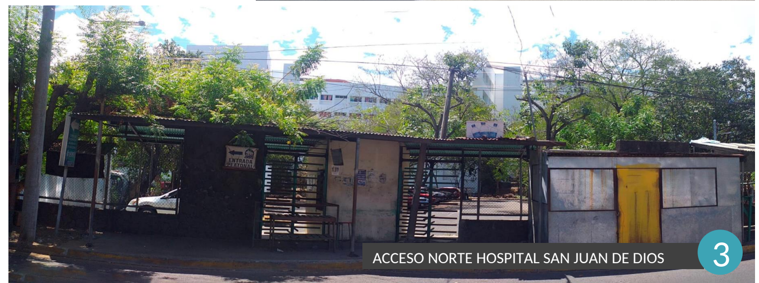
FACHADA NORTE HOSPITAL SAN JUAN DE DIOS
