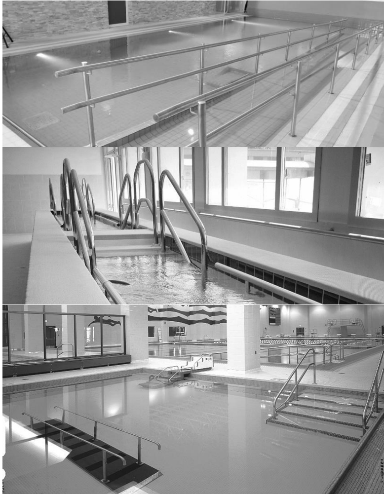
Imagen 10- Ejemplos de instalaciones para hidroterapia. Fuente: www.natare.com
