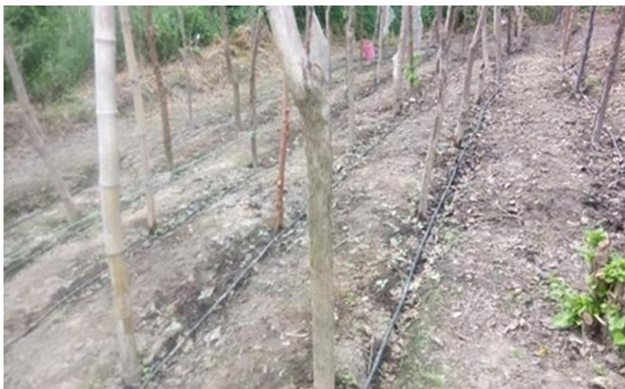
Figura A-8 Instalación sistema de riego del por goteo en la parcela.
