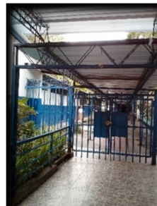
Figura 129. Zona de transición e ingreso del INCO
