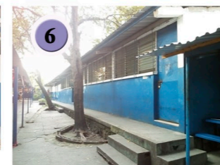
Fig 92. Fachada principal del Módulo de Aulas "A"
