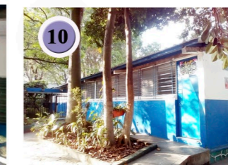
Fig 94. Fachada principal del Módulo de Aulas "B"
