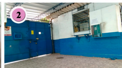
Fig. 88 Caseta de vigilancia localizada contiguo al portón de acceso peatonal.
