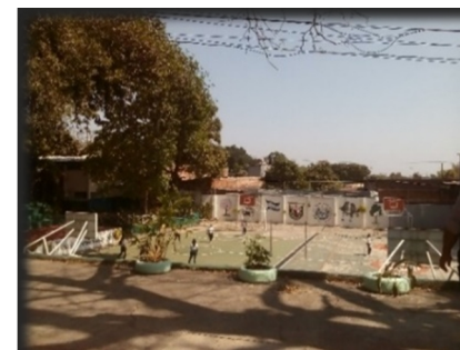
Fig.3. En el área de canchas, se requiere la colocación de un techo debido a que en este lugar se realizan múltiples actividades (entrenos, reuniones de padres de familia), que se ven interrumpidas por las inclemencias climáticas.
