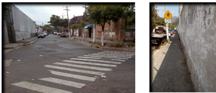
Figura 41 y 42. Fotografías de Calle Campos y su correspondiente acera peatonal
