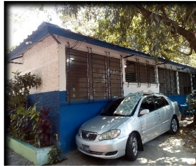
Figura 136. Estacionamiento improvisado al interior del INCO.
