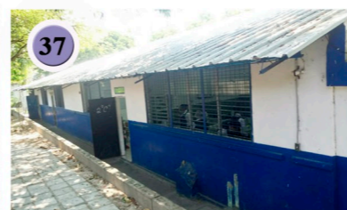
Fig 114. Módulo de aulas "I"
