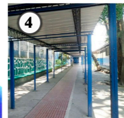
Fig 90. Pasillo techado frente a Módulo de Aulas "A".
