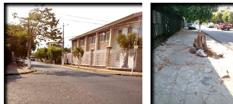
Figura 45 y 46. Fotografías de Calle Lara y su correspondiente acera peatonal
