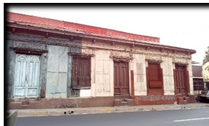
Fig.23. Fachada principal de casa antigua ubicada frente a 10ª Calle Poniente. Fuente: Elaboración propia
