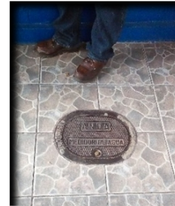
Figura 121. ANDA provee el servicio de agua potable al INCO.
