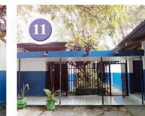
Fig 95. Acceso a los servicios sanitarios y oficina de contabilidad en administración.
