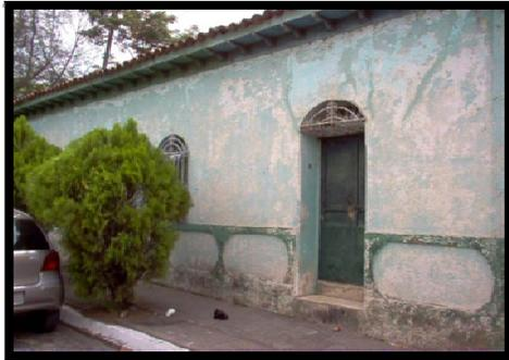
**FOTO 68:** Tipología de vivienda. Los materiales varían, pero prevalecen las edificaciones de adobe, teja de barro y piso de ladrillo de cemento.-
