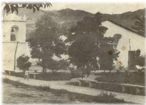
Foto 1: Iglesia y Parque Central, 1965.
