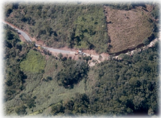
Foto 17: Tramo del Anillo Periférico La Montaña
