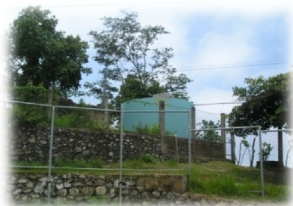
Foto 9: Tanque de Captación de Agua.
