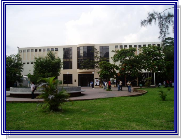
Imagen 3.21 (Edificio Administración Académica FIA)
