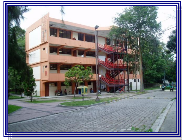
Imagen 3.20 (Edificio de aulas B)
