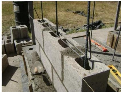
**Figura 3. 17 Acero de refuerzo horizontal.**
