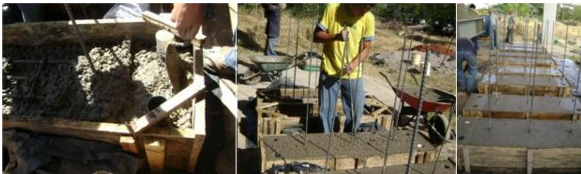
**Figura 3. 14 Colado de solera de fundación.**
