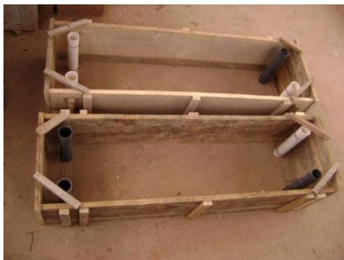
**Figura 3. 10 Encofrados para soleras de fundación.**
