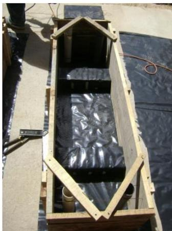
**Figura 3. 11 Piezas de adobo colocado en los encofrados.**
