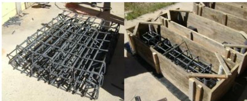
**Figura 3. 12 Refuerzo de soleras de fundación.**
