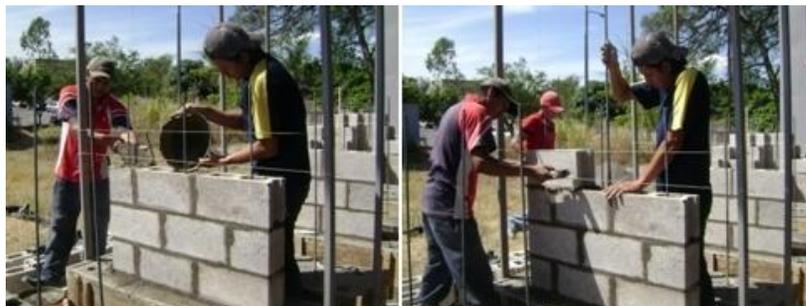
**Figura 3. 16 Llenado de celdas con grout.**
