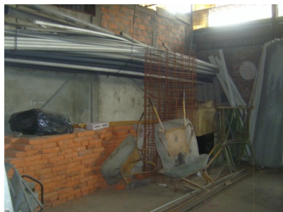
Imagen 125 (Bodega “Fontanería y Albañilería”)
