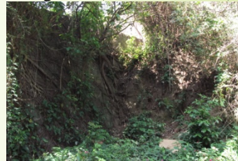
Imagen 93 (4-Puente de piedra)
