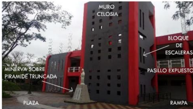
Edificio nuevo de aulas FMO
