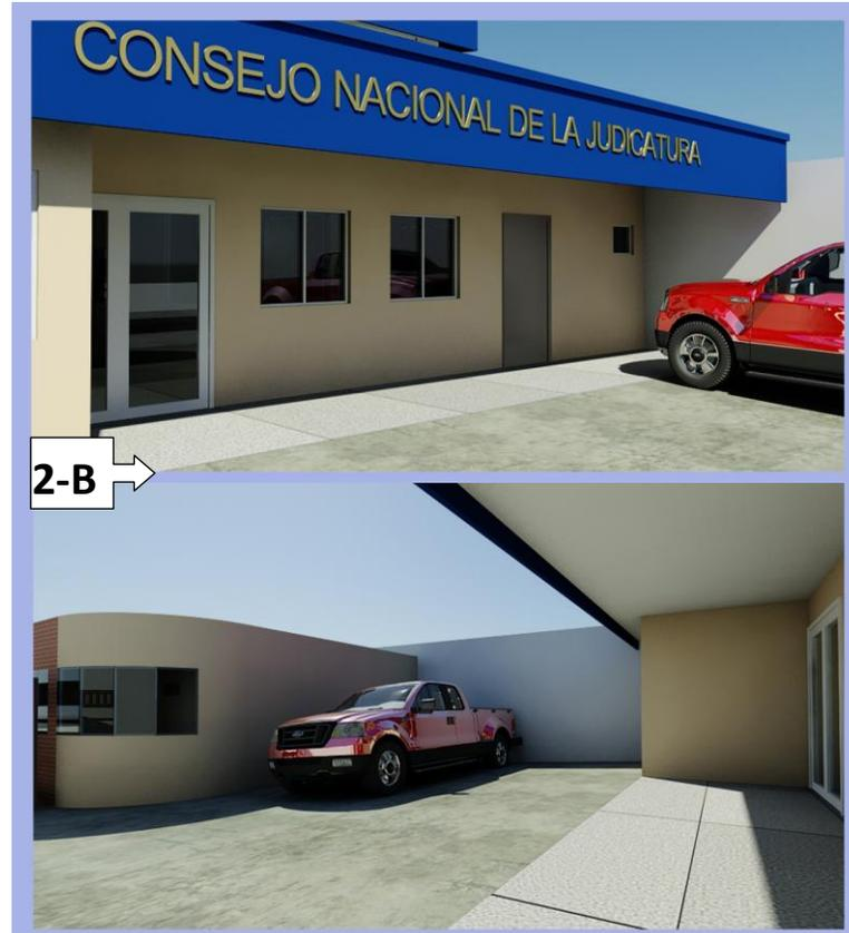
VISTA EXTERIOR DEL ACCESO a las oficinas administrativas. Paredes de bloque, puerta principal de vidrio de doble hoja, ventanas de pvc con vidrio fijo laminado, piso encementado para estacionamiento
