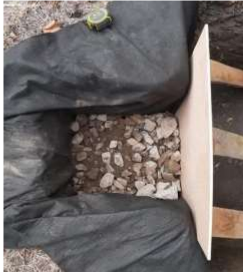
Figura 4.64 Colocación de Grava N.º 2
