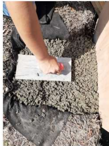
Figura 4.65 Colocación de mezcla in situ de concreto permeable
