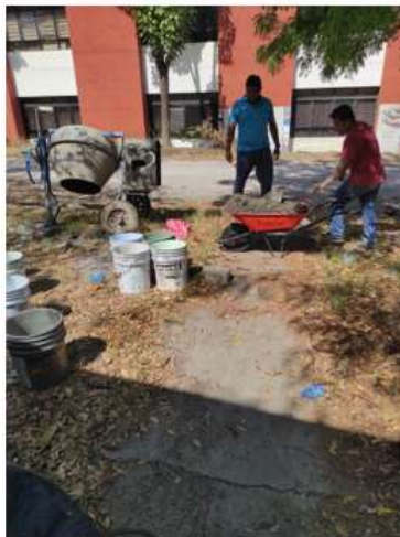
Figura 4.65 Colocación de mezcla in situ de concreto permeable
