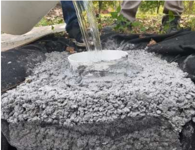
Figura 4.71 Colocación de agua proceso de pre humectación
