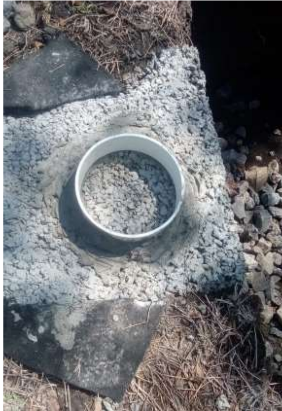
Figura 4.70 Anillo en losa de concreto permeable previo a pre - humectación
