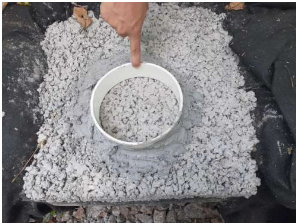
Figura 3.20 Instalación de anillo simple de 6”
