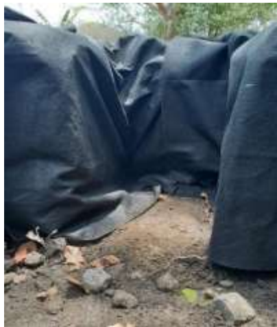
Figura 4.63 Geotextil no tejido en paredes adenañas
