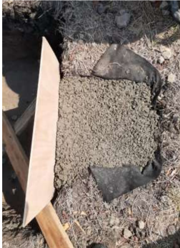
Figura 4. 66 Colocación de concreto permeable con 15 cm de espesor
