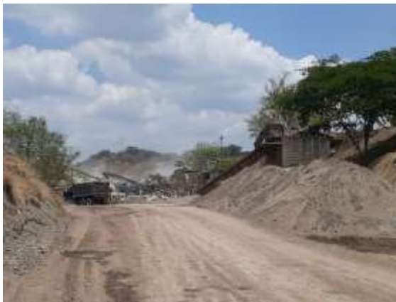
Figura 4.2 Instalaciones de la Cantera Sinaí
