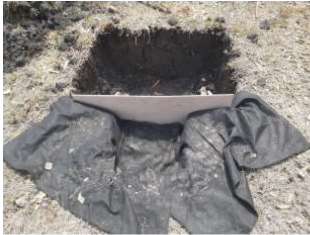
Figura 4.67 Geotextil estabilizador y aplicado a curación de concreto permeable
