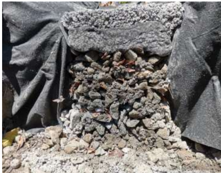
Figura 4.68 Estructura de concreto permeable
