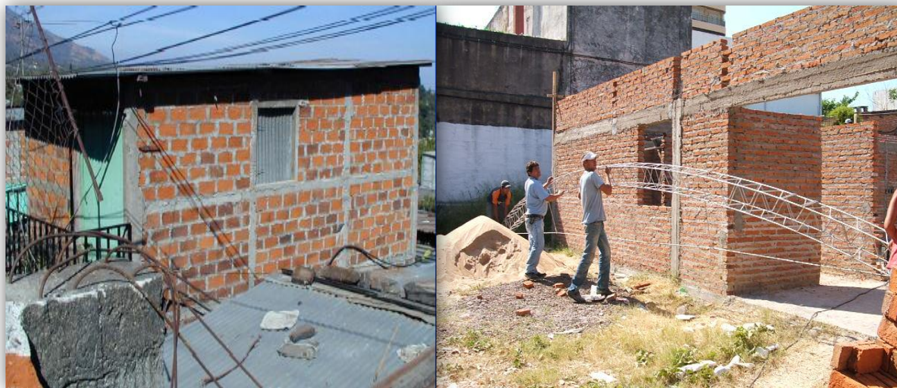
Edificación de Mampostería de Ladrillo de barro, Sistema estructural y sistema constructivo mixto.
