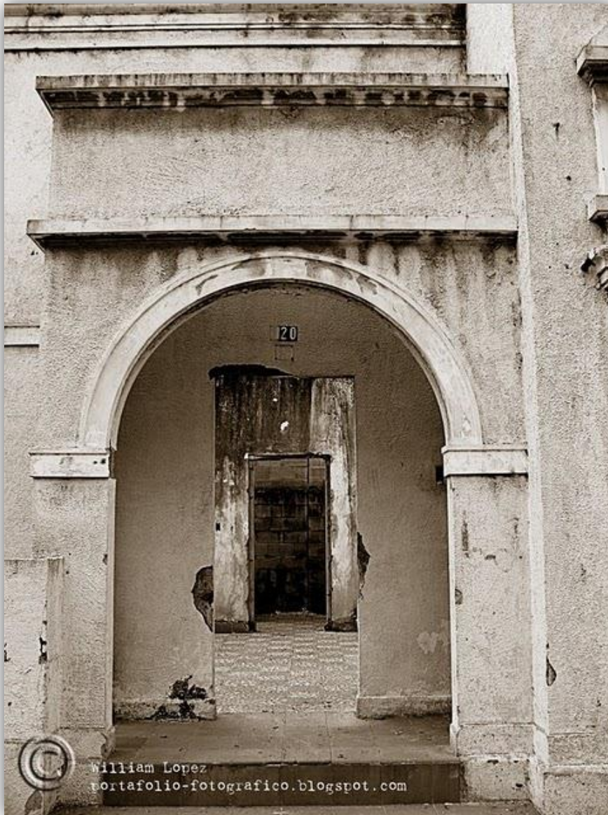
Portal de fachada Foto N°12
