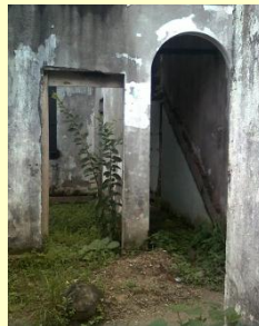
Se observan los dos tipos de puertas, cuadradas y con arco de medio punto.
