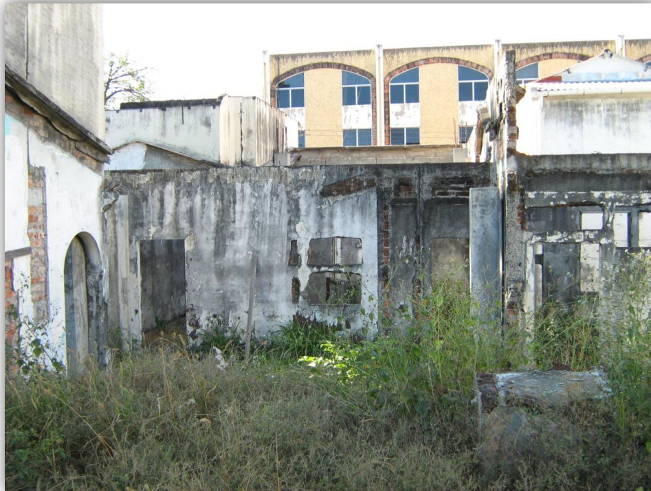
Interior del inmueble en estudio Foto N°11
