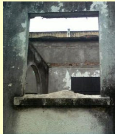
Otras ventanas son cuadradas con repisa, esta se observó en el área de servicio.
