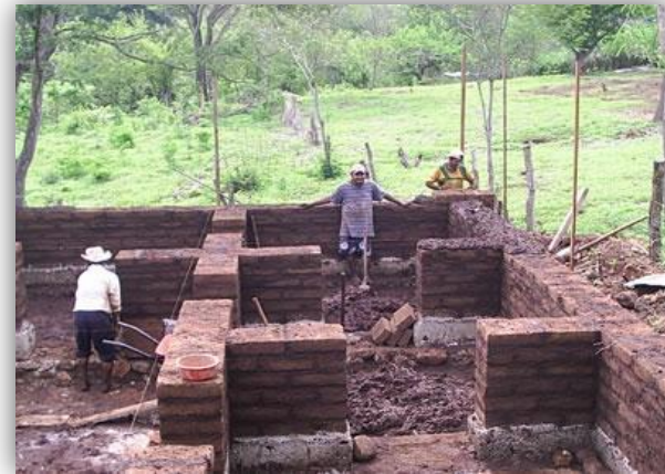
c) Colocación de ladrillos de barro cocido.
