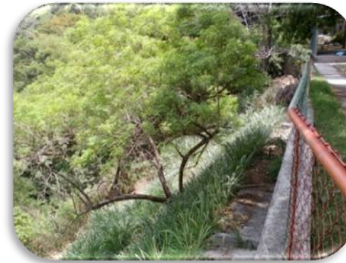
Foto 17. Vistas configuración de niveles del terreno,
