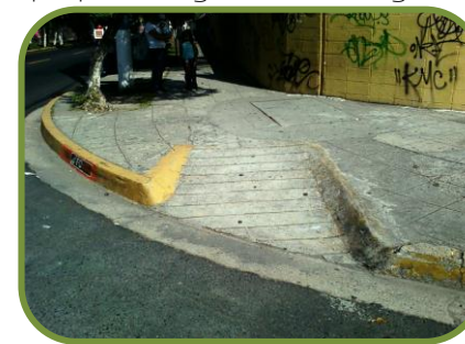
Foto N° 10. Rampas de acceso para personas con capacidades especiales
