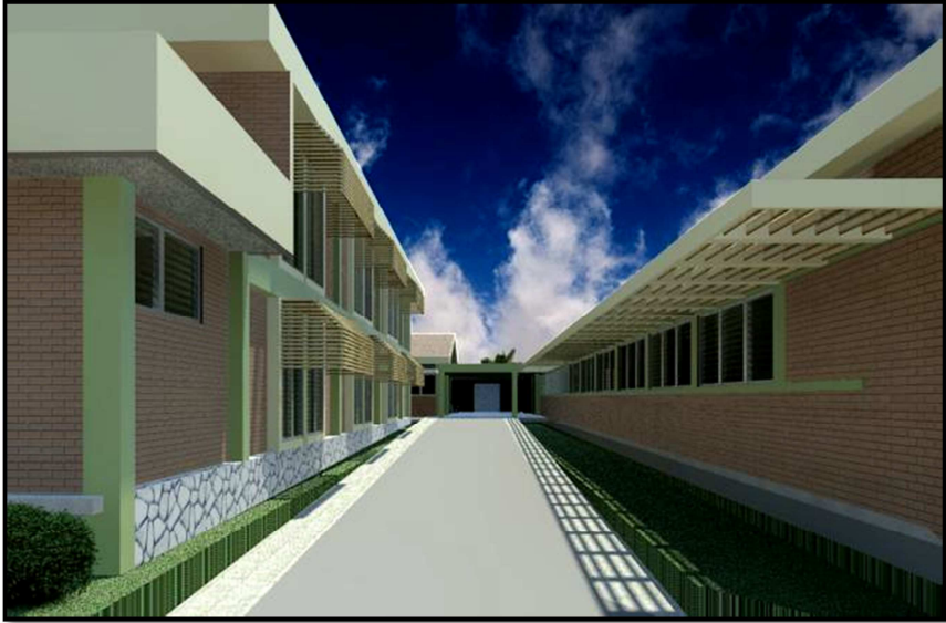
IMAGEN No.17 DIRECCIÓN Y ACCESO A LA ÁREA DE TECNICOS
