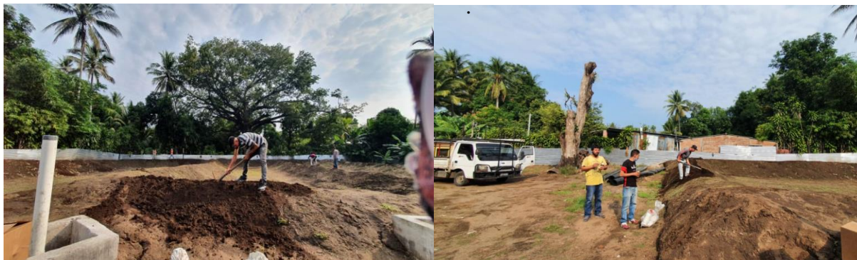
Foto 1. Construcción de estanques
