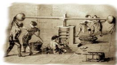
Prensa de Balancín de Nicolás Briot (1626), diseñada por Leonardo da Vinci, https://www.interempresas.net/MetalMecanica/Articulos/1435-Evolucion-tecnica-de-la-maquina-herramienta-Resena-historica.html .
