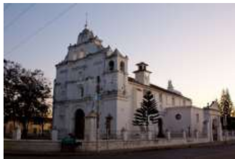
Fotografía 36: Iglesia Santiago Apóstol"
