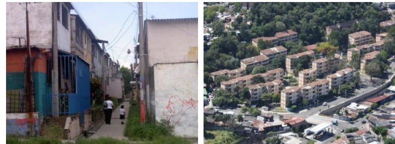
Imagen 10. La construcción de vivienda en altura, libera espacio siendo posible la dotación de un mejor entorno urbano a sus habitantes.
