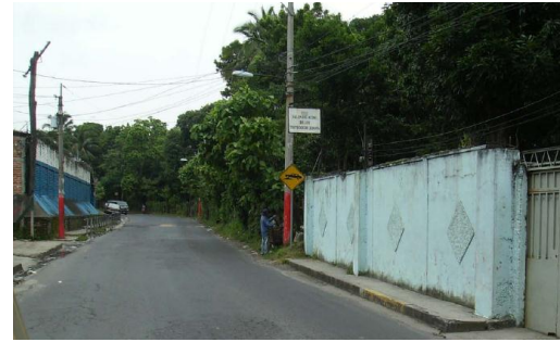
Imagen 44. Calle de acceso, Carretera a Tonacatepeque
