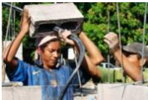
Imagen 30. Para el modelo cooperativo de vivienda por ayuda mutua es de mucha importancia La identificación de carpinteros, albañiles, mecánicos de banco, etc., garantizando entre los habitantes una fuerza de trabajo especializada para la ejecución de los proyectos de vivienda, lo que redundará en una reducción de costos de construcción.
