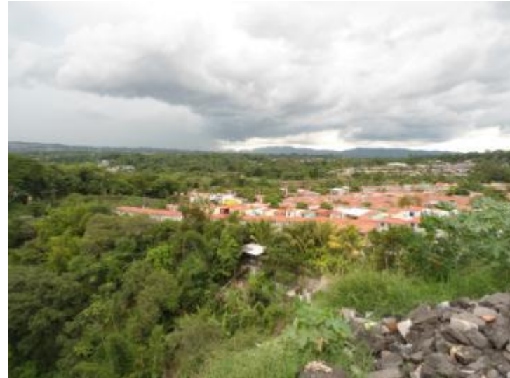
Imagen 38. Vista Residencial San Francisco, viviendas cercanas a la zona de protección
