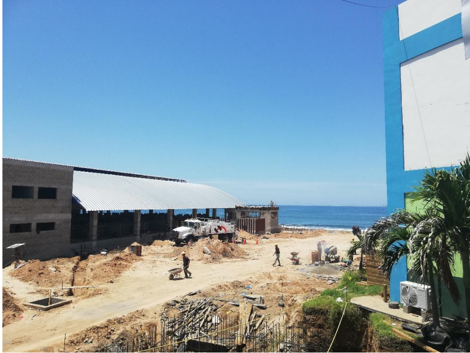
Vista de la construcción desde pasarela
