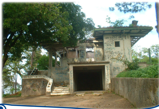
En la fotografía se observa la fachada Poniente la cual muestra el acceso principal a la casa.
