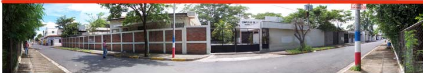
vista panoramica de terreno hacia colindante sobre 9a avenida norte
