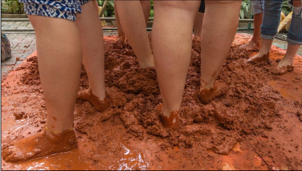
Figura 8: Proceso de mezcla de los materiales. Fuente: Baú / Escola da Cidade
