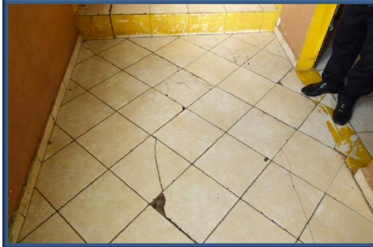
*Imagen 10: Piso dañado; quebrado o con fisuras*
