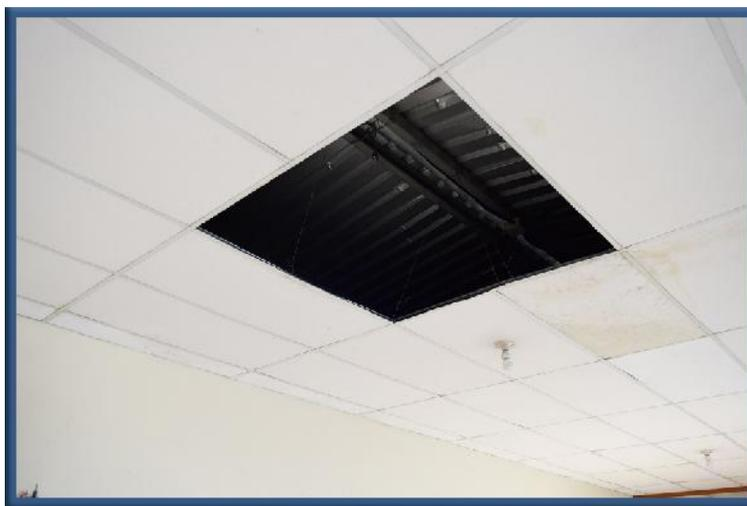
*Imagen 9: Deterioro en el cielo falso: faltantes, quebradas o manchadas*
