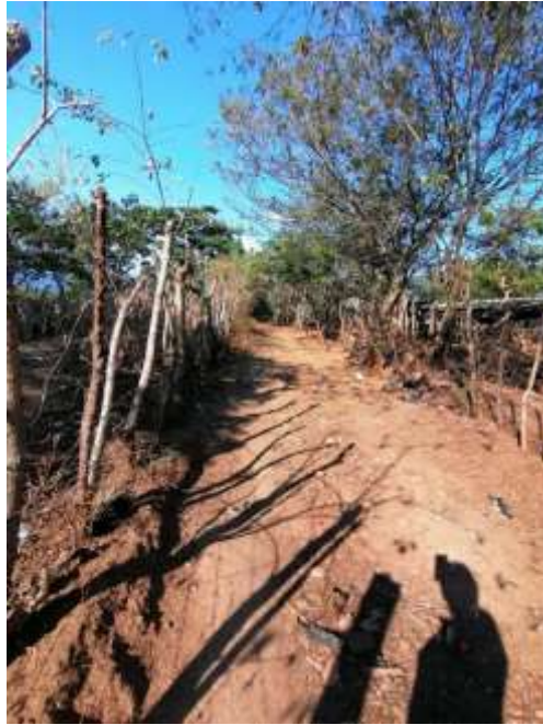
Fotografía N°3. Tramo de la línea impelencia.
