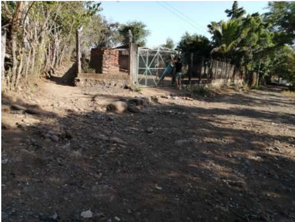
Fotografía N°6 tramo línea de distribución.
