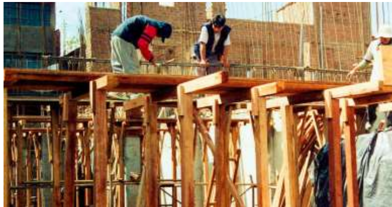
Figura 2-1. Encofrados de entepiso mediante madera aserrada. Civilgeeks (2012).
