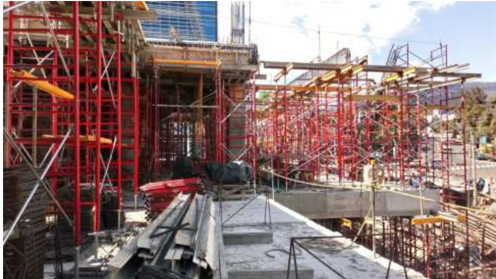
Figura 2-12. Apuntalamiento mediante andamio de carga. Martínez, (2019).
