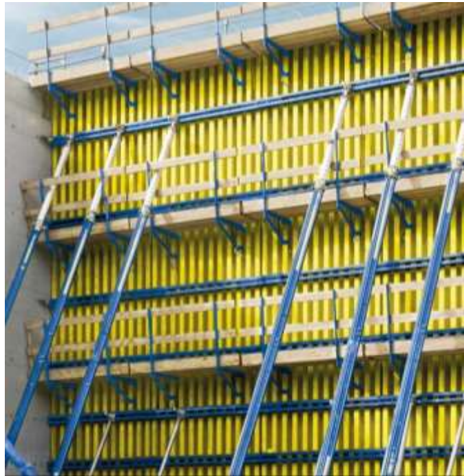
Figura 2-3. Encofrado de muros a un rostro mediante el sistema de vigas H20. Doka, (2019)
