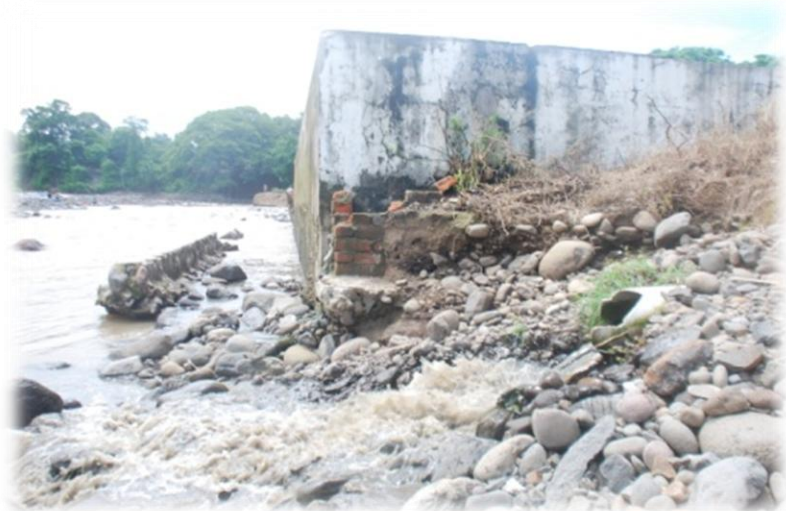
Ilustración 80 - Planta de tratamiento de aguas negras
