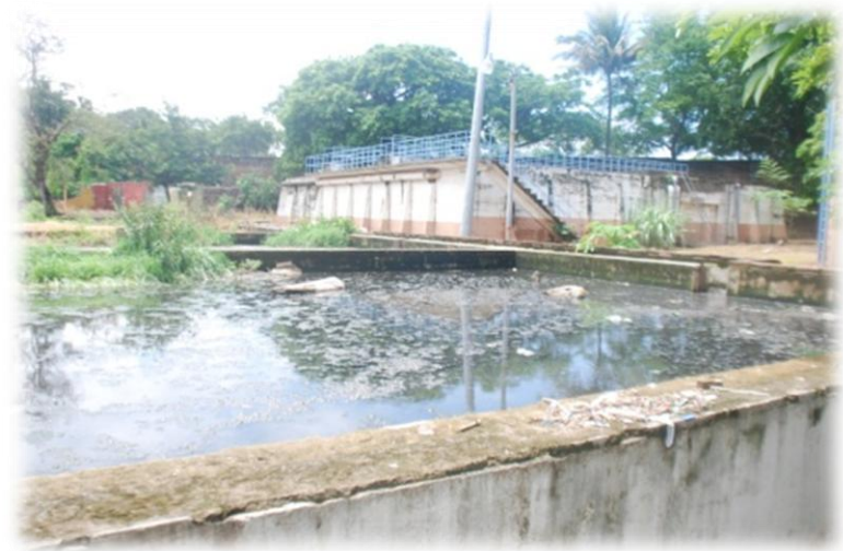
Ilustración 81 - Planta de tratamiento de aguas negras
