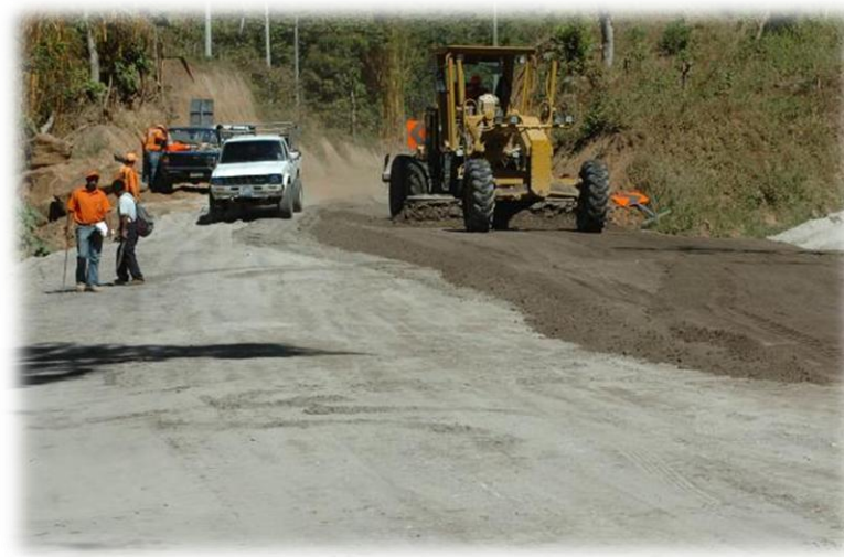
Ilustración 5 – Proceso de ampliación carretera hacia el Puerto de La Libertad (proyecto ya finalizado)
