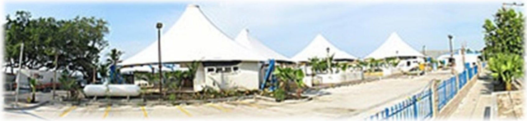
Ilustración 51 - Vista al poniente - Kioscos del Malecon
