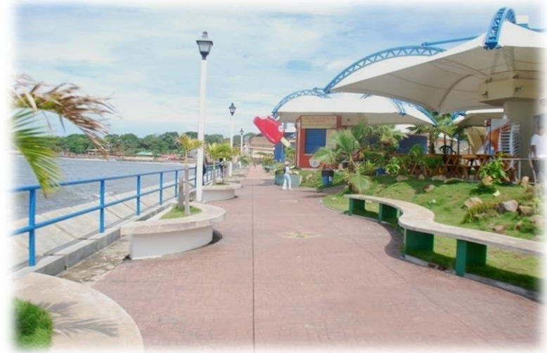
Ilustración 21 - Zona Peatonal área de restaurantes-Malecón 1ra etapa
