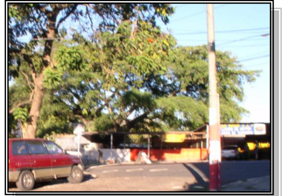
Tramo de acera sobre la Avenida Don Bosco utilizado como "car wash", por el tipo de instalaciones inadecuadas rompe con la continuidad visual de esa avenida.
