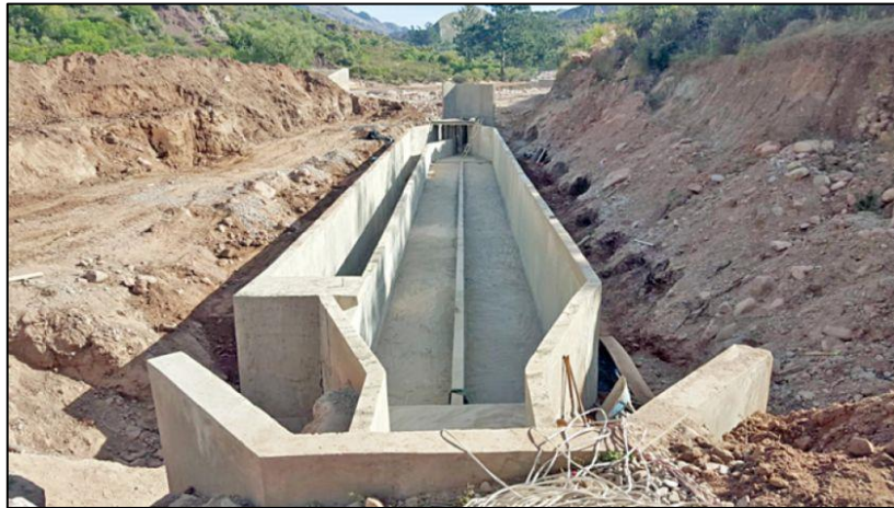
Ilustración 2-7, desarenador típico
