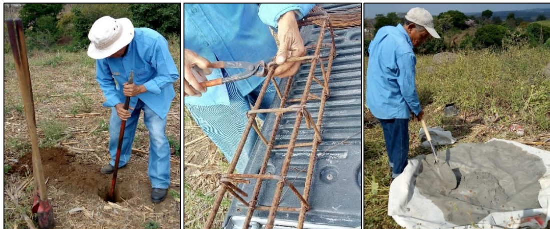
Figura 5.7 Actividades de monumentación: excavación, armado de acero y realización de mezcla.
