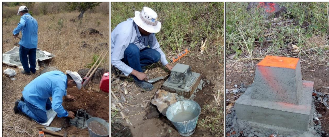
Figura 5.8 Actividades de monumentación: vaciado de concreto y acabado final del vértice.
