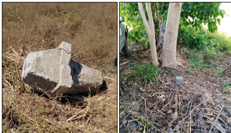
Figura 5.5 Vértices geodésicos destruidos y obstruidos.
