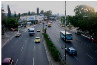
Vista de Carretera a Santa Tecla. (Carretera Panamericana)
