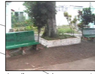
Jardineras de concreto estado regular
