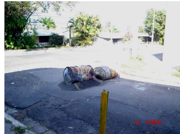
Avenida Caoba, con obstáculos en medio de la calle, para evitar que las tuberías se continúen deteriorando.
