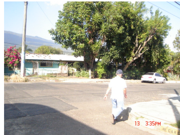
4a Calle Poniente. Calle principal, con deterioro en su recubrimiento.
