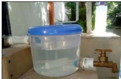
**Figura 4.20 Cuarta etapa del sistema de potabilización (Desinfección mediante cloración).**
