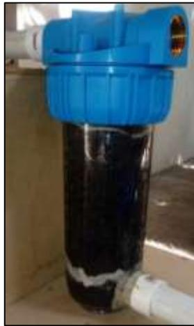
**Figura 4.19 Tercera etapa del sistema de potabilización en el experimento óptimo (Remoción de Plomo).**
