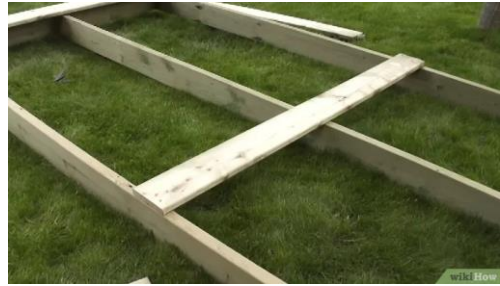
Ilustración 56: Soportes para Marco de Muelle
