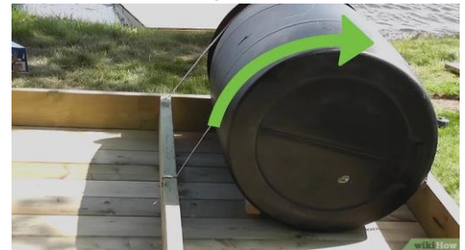
Ilustración 60: Armellas de Soporte para Barriles
