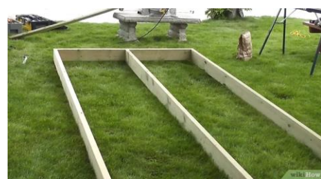
Ilustración 54: Marco de Soporte para Muelle
