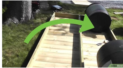
Ilustración 61: Muelle Parcialmente Terminado
