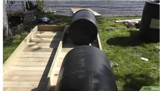
Ilustración 56: Soportes para Marco de Muelle
