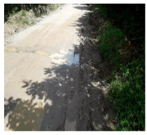
Imagen 2. 10 Ablandamiento de la superficie de rodadura por el agua estancada.
