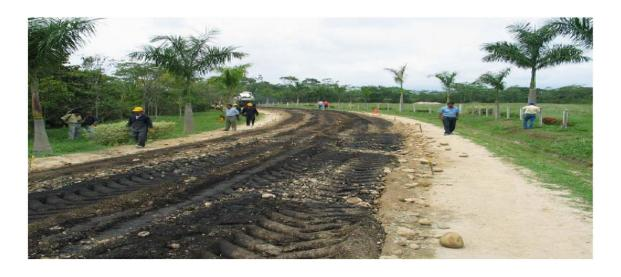
Imagen 2. 30 Aplicación de una emulsión asfáltica en la estabilización de sub-rasantes y bases para pavimento.
