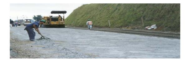
Imagen 2. 29 Aplicación de cemento en la estabilización de subrasantes para pavimentos.
