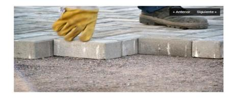
Imagen 2. 27 Colocación de adoquines.
