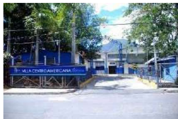
MOJÓN: VILLA CENTROAMERICANA Fuente: Visita de campo
