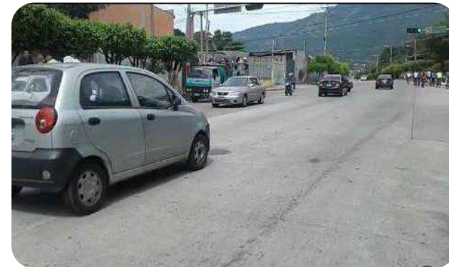
Foto 2. Estado actual de la Calle al Volcán Fuente: visita de campo 11/05/2018
