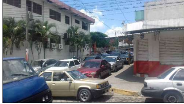
PLAZA LA REFORMA ACTUAL
