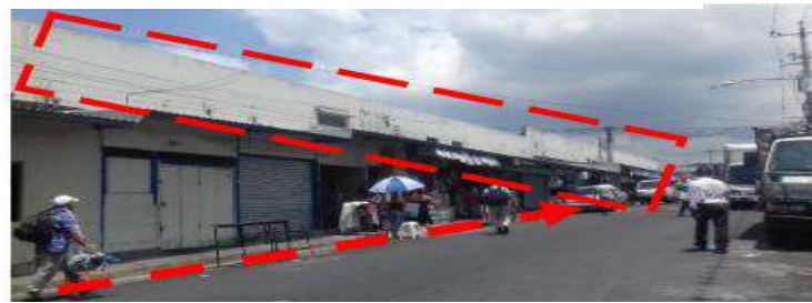
Foto 18. Obstaculización de aceras y dimensión muy angosta
