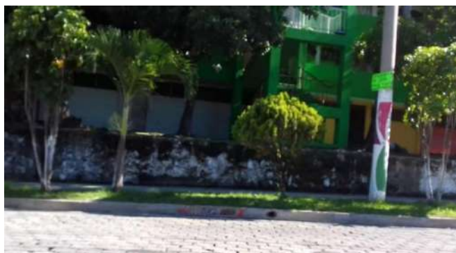
Foto 20.. Murete inicial del tramo
