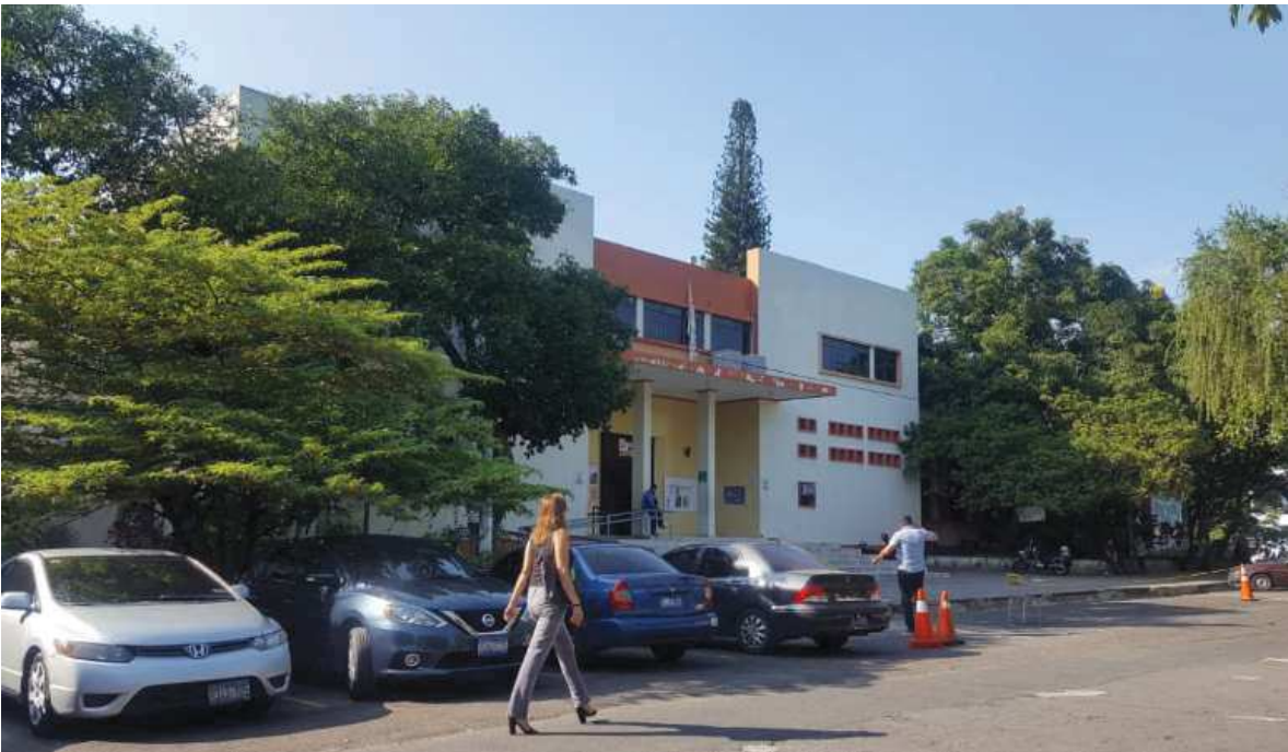
Ilustración 60: Edificio de Jurisprudencia y Ciencias Sociales.
