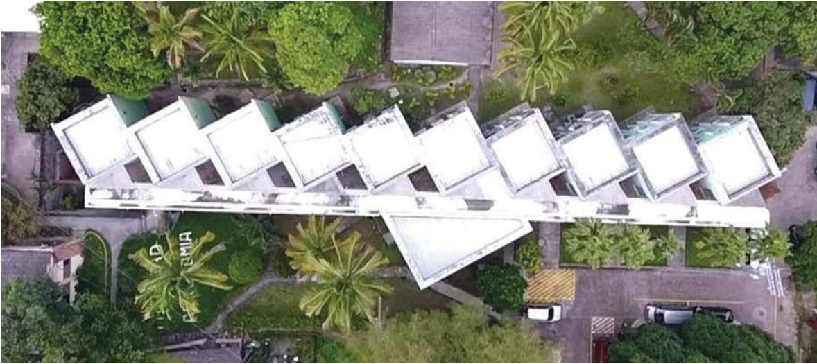
Ilustración 68: Imagen de vista superior del edificio Administrativo de Ciencias Agronómicas.
