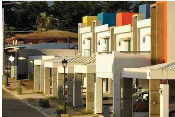
Ilustración 101: Como se puede observar el hecho de ser una distribución eléctrica subterránea mejora el entorno estético de gran manera.
