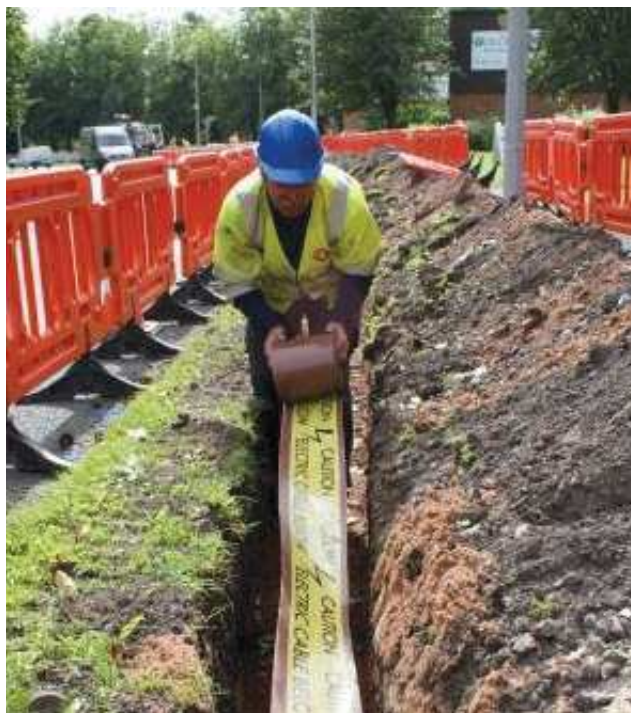
Ilustración 121: Colocación de cinta o banda de advertencia en la excavación del trayecto del ducto subterráneo.
