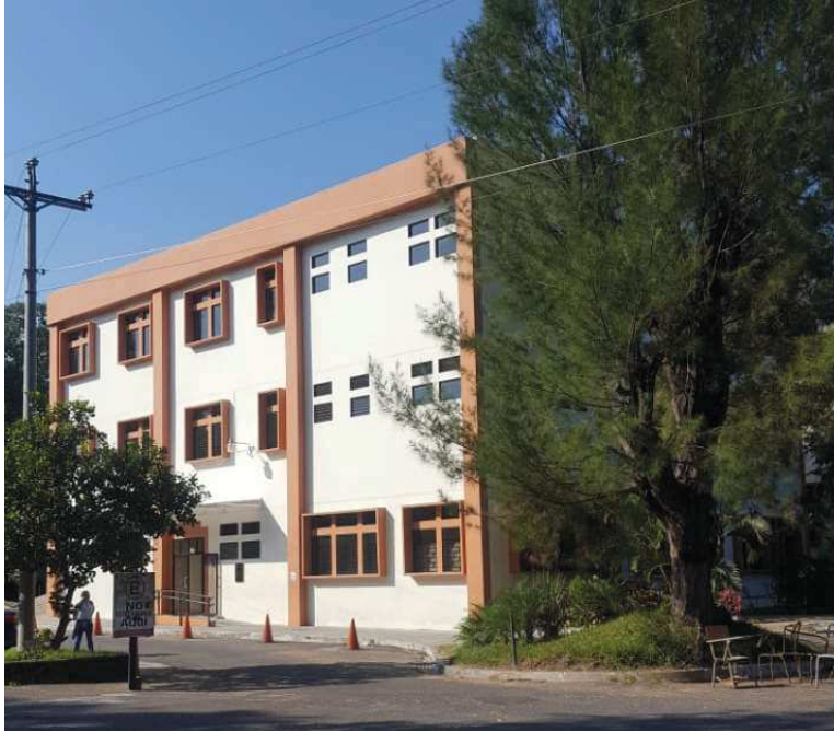
Ilustración 64: Edificio de usos múltiples imagen lateral.
