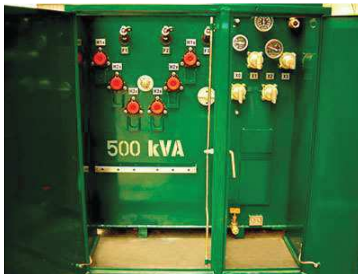
Ilustración 105: Imagen de un transformador tipo pedestal para configuración en anillo.
