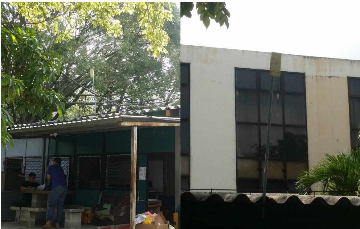
Mesh180 ubicado en ASEIC
