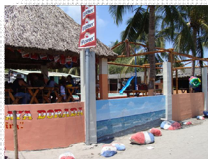
Imagen 26: Estructura de Concreto
