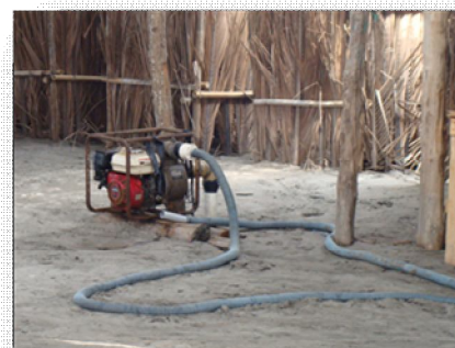
Imagen 25: extracción de agua con bomba
