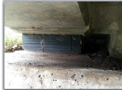
Imagen 22: Ejemplos de aparatos de apoyos en puentes.
