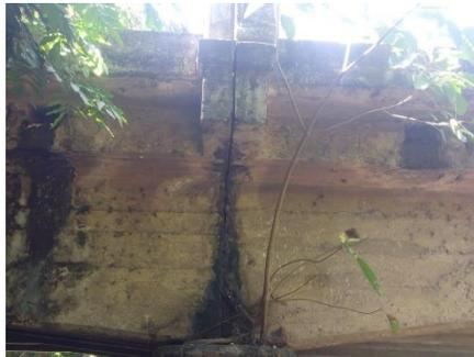
**Imagen 4.27: Deformación del elemento de junta**
