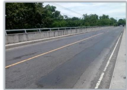
Imagen 35: Ejemplo de superficie de rodadura en puente.
