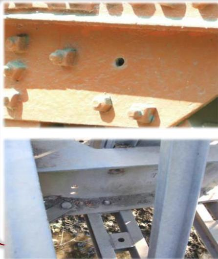
La falta de alguno de estos elementos de conexión se puede dar debido a fatiga. Los pernos o remaches en la conexión de los elementos deberán ser verificados cuidadosamente durante la inspección, sobre todo cuando la estructura principal del puente es metálica.
