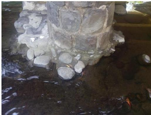
**Imagen 4.26: Presencia de socavación en fundación de pila y desprendimiento de material de zapata.**
