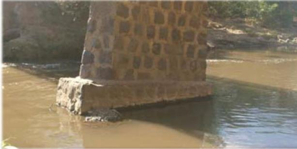
Fundaciones que han cedido o asentado. Cuando este daño se aprecia en un puente, existen desplazamientos en la estructura originados en el cedimiento de algunas fundaciones.
