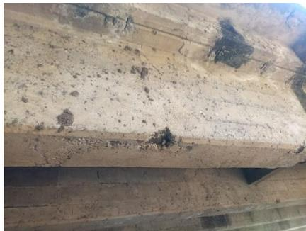
**Imagen 4.23: colmenas en vigas longitudinales.**
