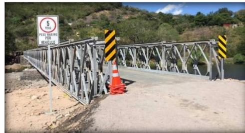
Imagen 9: Puente metálico tipo Bailey.
