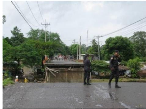
**Imagen 1.7: Puente Ateos colapsado debido a depresión tropical DOCE-E en 2011.**
