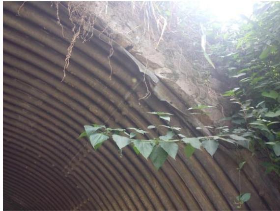
**Imagen 4.34: Abolladura en arco metálico.**
