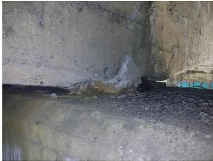
**Imagen 4.20: Asentamiento de vigas longitudinales en pilas y apoyos destruidos.**
