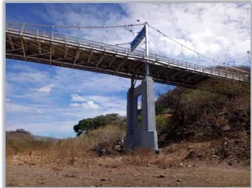
Imagen 31: Ejemplo de pila en puentes.
