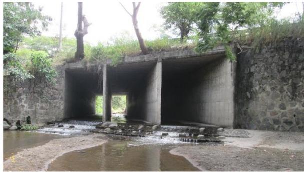
Imagen 12: Puente tipo losa en forma de caja.
