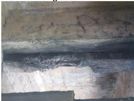
**Imagen 4.24: fisuras y desprendimiento de concreto en vigas transversales.**
