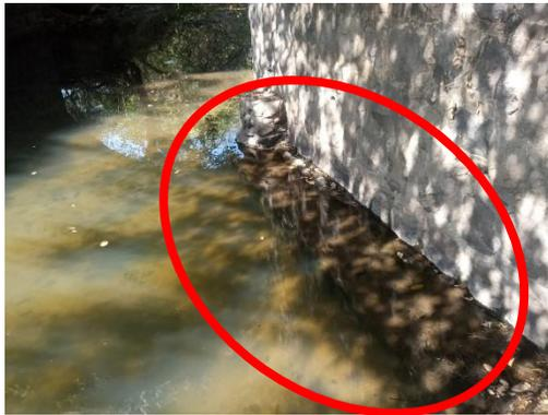
**Imagen 4.31: socavación en la fundación en muros interiores y aletones**
