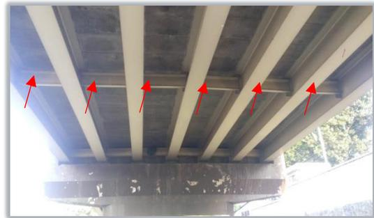
Imagen 38: Ejemplo de viga transversal o viga riostra en puentes.
