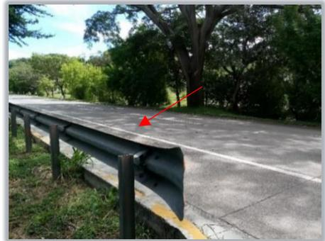
Imagen 25: Ejemplo de defensa de tráfico tipo Flex beam.
