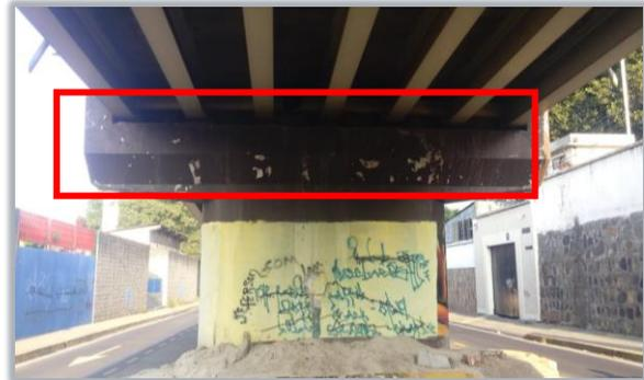
Imagen 37: Ejemplo de viga de apoyo en pilas.
