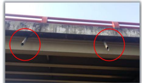
Imagen 26: Ejemplo de drenaje para desalojo de agua en un puente.
