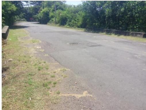
**Imagen 4.30: baches, suciedad y crecimiento de vegetación en la capa de rodadura**
