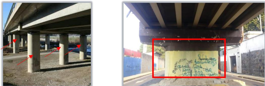
Imagen 29: ejemplos de fuste en pilas de puentes.
