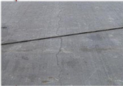
Estas grietas, que dividen la losa en dos o tres pedazos, son causadas usualmente por una combinación de la repetición de las cargas de tránsito y el alabeo por gradiente térmico o de humedad.
