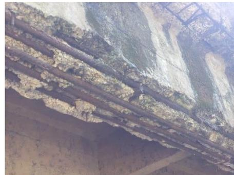
**Imagen 4.25: desprendimiento de concreto, concreto manchado y corrosión de acero de refuerzo en vigas longitudinales**
