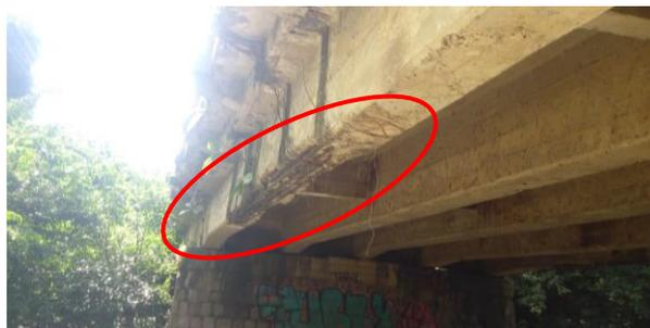
**Imagen 4.3: Daño de recubrimiento saltado y Corrosión del acero en concreto en elemento de viga.**
