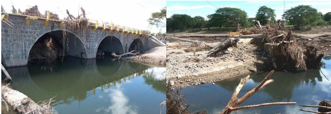
**Imagen 1.11: Colapso de puente Titihuapa debido a obstrucción en el paso del cauce del río.**
