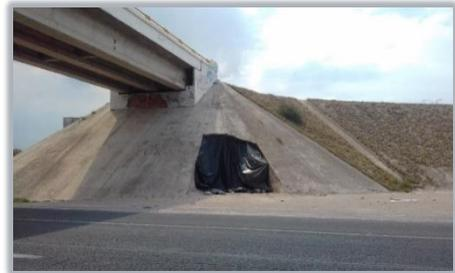
Imagen 32: Ejemplo de revestimiento de concreto en cono de derrame.
