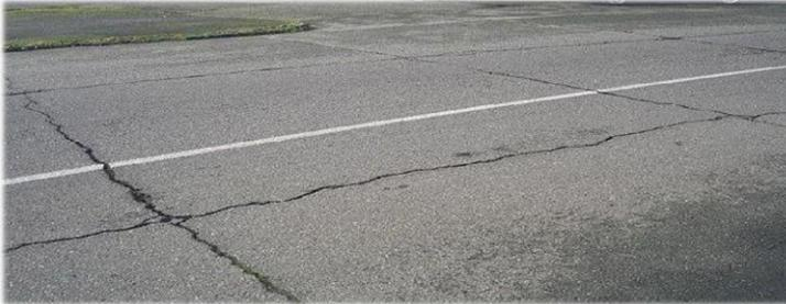
Estas grietas son causadas principalmente por el movimiento de la losa de concreto de cemento Pórtland, inducido por temperatura o humedad, bajo la superficie de concreto asfáltico. Este daño no
