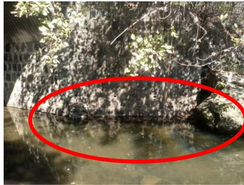
**Imagen 4.32: socavación en la fundación en muros interiores y aletones.**
