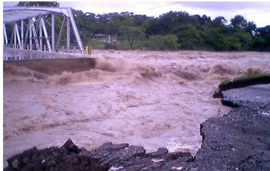
**Imagen 1.8: El puente Arce sobre el río Paz, en frontera con Guatemala, fue socavado debido a intensidad de tormenta.**
