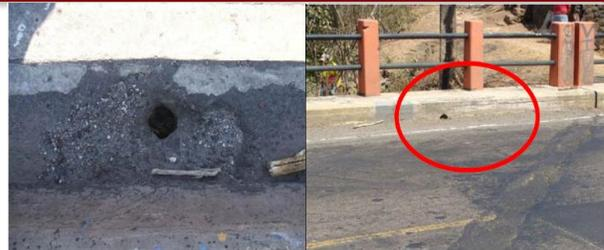
Generalmente este tipo de daño surge por un error en la construcción del puente, cuando el sistema para desalojo de agua de la capa de rodadura queda unos centímetros más altos que la rasante del puente.
