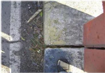
Residuos de basura o partículas de suelo, acumulados en juntas, apoyos, drenajes, aceras, cordones, entre otros elementos del puente, generando obstrucciones.
