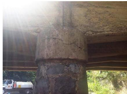
**Imagen 4.23: Grieta en viga de apoyo en pila.**
