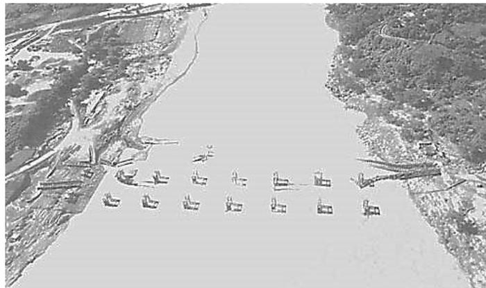
**Imagen 1.5: Puente tipo Bailey sobre el río Lempa, colapsado por lluvias. Ubicado sobre carretera Panamericana. (Puente “Cuscatlán”).**
