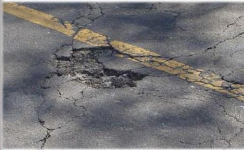
La desintegración del pavimento progresa debido a mezclas pobres en la superficie, puntos débiles de la base o la subrasante, o porque se ha alcanzado una condición de piel de cocodrilo de severidad alta. Con frecuencia los baches son daños asociados a la condición de la estructura y no deben confundirse con desprendimiento o meteorización.
