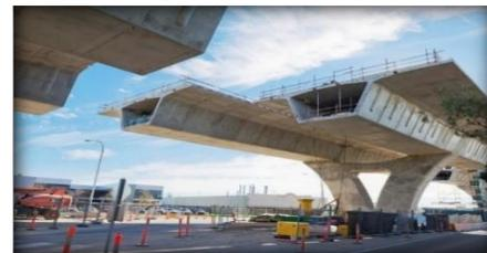
Imagen 7: Puente con vigas cajón.
