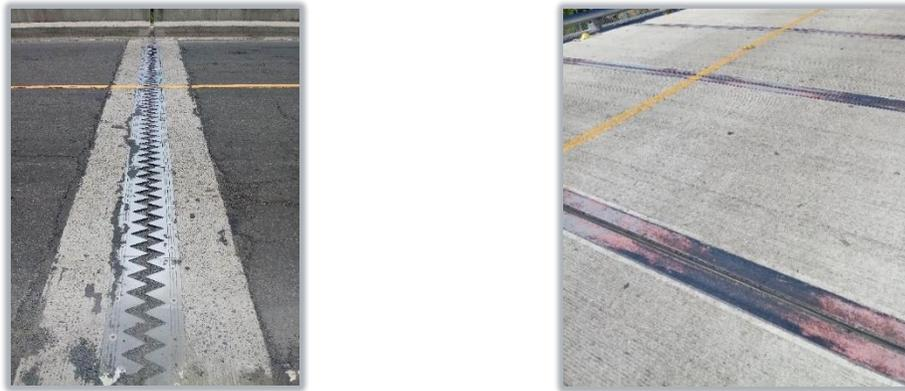
Imagen 30: Ejemplos de juntas en puentes
