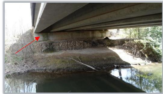
Imagen 28: Ejemplo de estribo en un puente.
