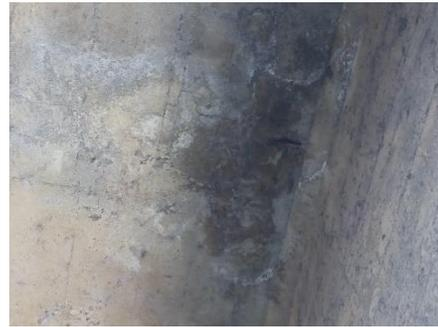
**Imagen 4.21: presencia de humedad y eflorescencias en la losa.**
