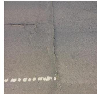
**Imagen 4.28: Obstrucción en juntas por sobre capas de asfalto**
