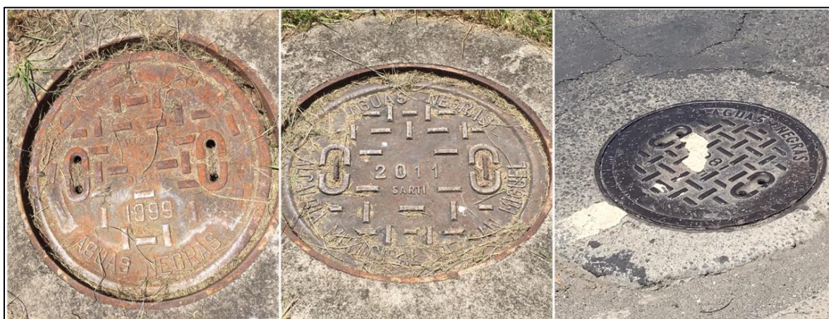
Figura 3.6 Pozos de aguas negras
