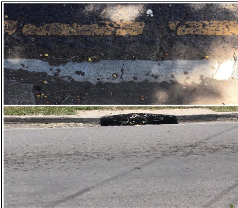
Figura 3.14 Desgaste de carpeta
