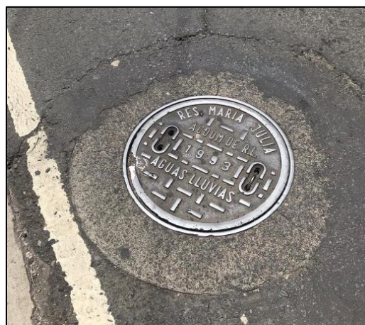
Figura 3.7 Pozo de aguas lluvias
