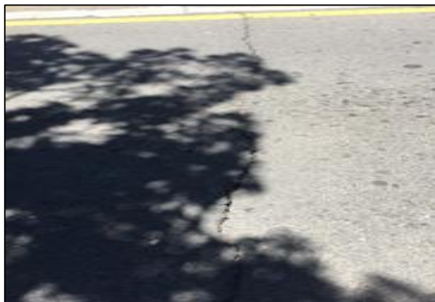
Figura 3.10 Fisura Transversal
