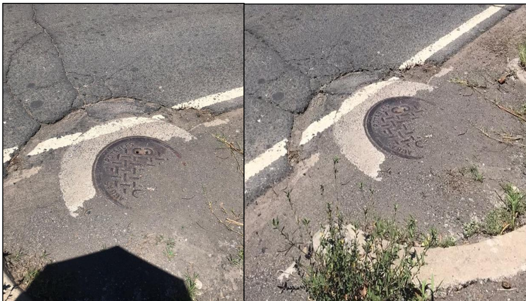
Figuras 3.8 Pozos de agua potable
