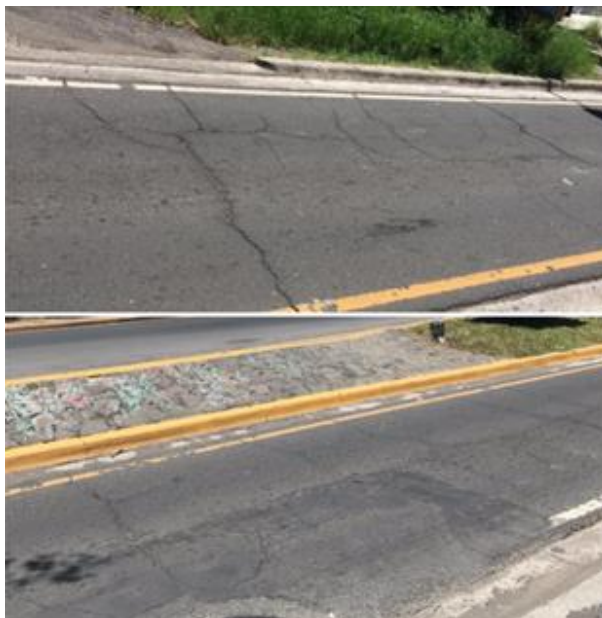
Figura 4.17 Grietas transversales.
