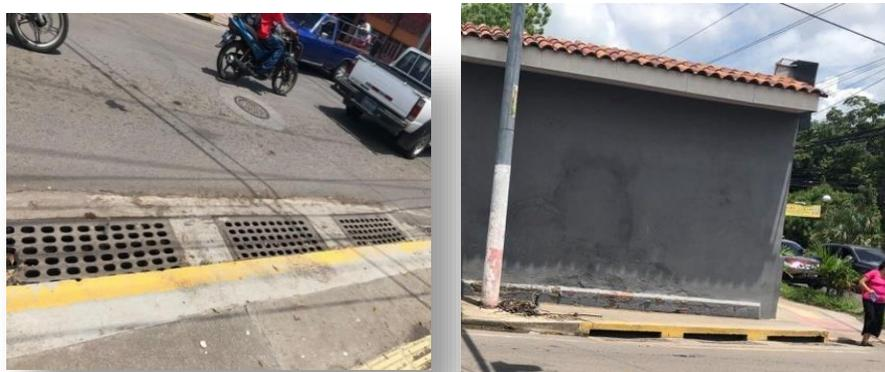
El estado actual de las obras de drenaje pluvial es de regular a bueno, en las cunetas se acumula basura y el agua se estacan, en la intersección de la 23<sup>a</sup> Avenida sur con la calle Chaparrastique se observa como el agua que transita por la cuneta se queda estancada y genera ‘charco’ entre la cuneta y la calzada de concreto, como se muestra a continuación:
