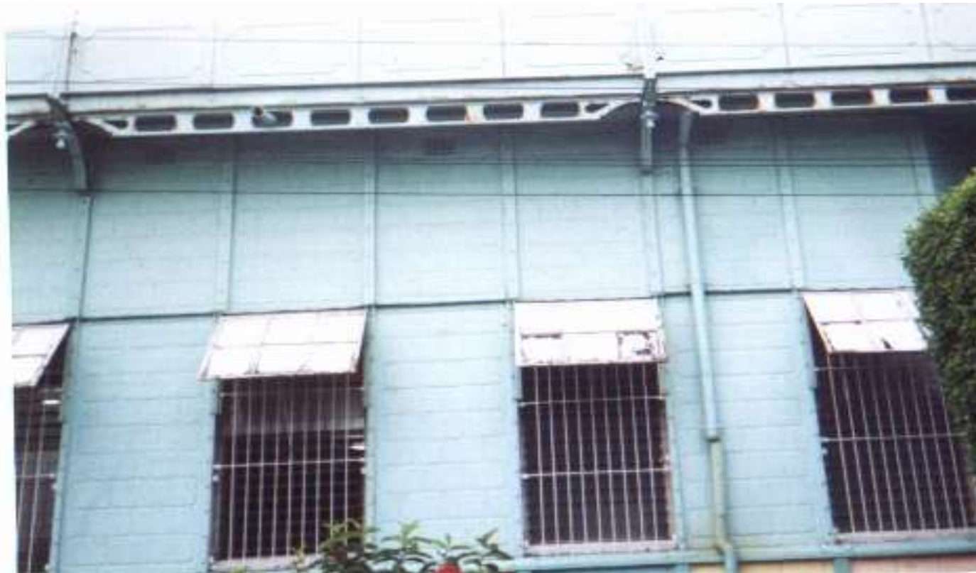
FOTO No 14 Modulación de lámina Troquelada. Exterior Del Edificio
