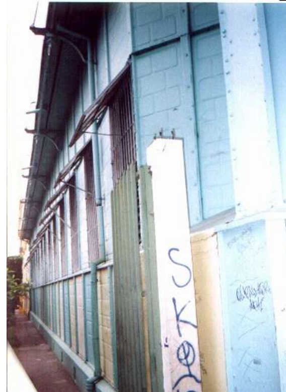
FOTO No 5 Vista de fachada oriente sobre Avenida Cuscatancingo, pueden observarse algunos de las adiciones realizadas al edificio externamente.
