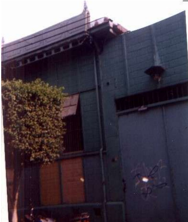
FOTO No 4 Estructuras modulares ensambladas a través de pernos. Vista acceso a cochera.
