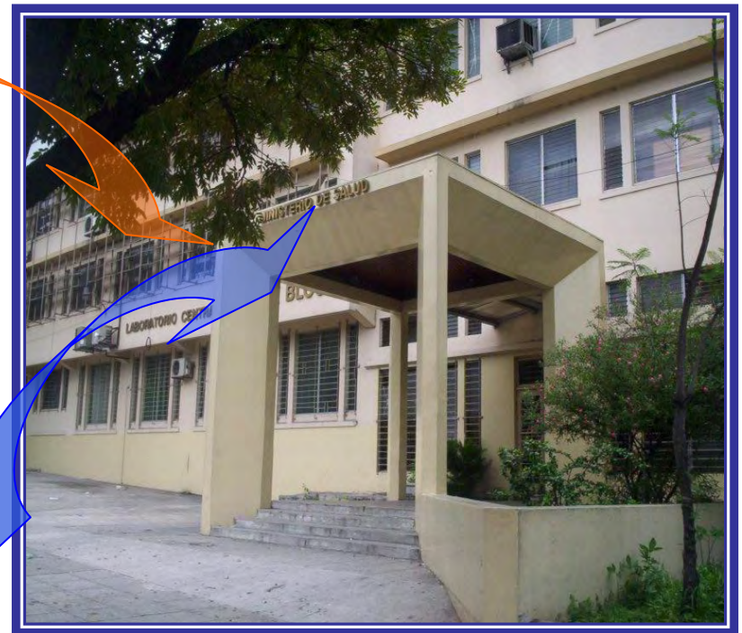
Fachada Principal del Laboratorio Central
