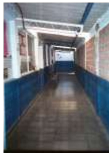
Circulación ( pasillo ) a lo largo de aulas
