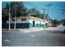
Oficina de telecomunicación
