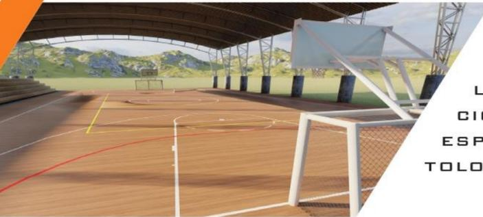
LA CUBIERTA CURVA DE LA CANCHA DE BASQUETBOL DESCANSA SOBRE UNA ESTRUCTURA DE ACERO APOYADA SOBRE PILARES DE CONCRETO ARMADO, PROPORCIONANDO PROTECCIÓN A JUGADORES Y ESPECTADORES DE LAS CONDICIONES CLIMATOLÓGICAS.
