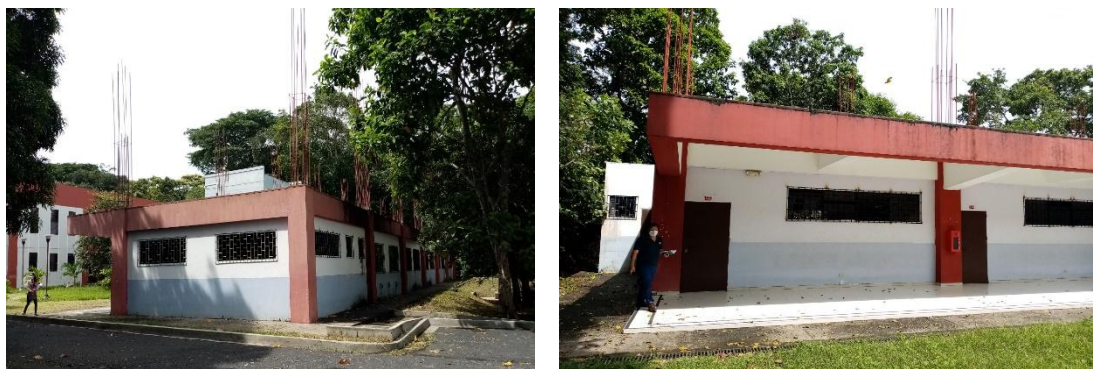
Fotografías 8, 9, 10,11 y 12. Instalaciones del Edificio del Programa Jóvenes Talento sobre el cual se pretende llevar a cabo la implementación de la nueva Clínica de Bienestar Universitario FMOcc.
